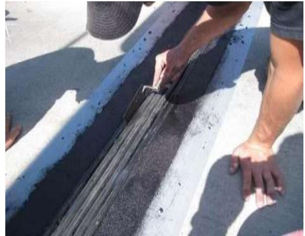
8. Repita el proceso hasta que la junta de expansión esté completamente llena por ambos lados. Después de completar la junta de expansión, retire con cuidado la cinta adhesiva protectora y el papel protector. No deje este material en su lugar durante el curado, ya que no se quitará fácilmente si se deja reposar durante la noche. Permita que el material desarrolle un curado completo durante la noche o hasta que el material del cabezal esté duro al tacto.
