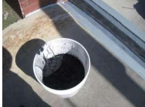
5. Vierta las proporciones medidas de Polycrete 1600 (Partes A y B) en el balde de mezcla de 5 o 6 galones. Mezcle bien los dos componentes, aproximadamente 1 minuto. Comience a agregar arena (Parte C) a las resinas mientras gira la mezcladora. Debería tomar un minuto agregar gradualmente la arena a la mezcla. Asegúrese de que todas las partículas de arena estén cubiertas; no debe haber bolsas de arena en la mezcla.
